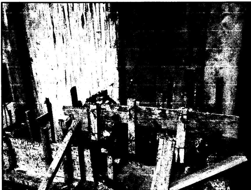
FOTOGRAFIA 01: Trabajos en maniluvio, lavabotas.
